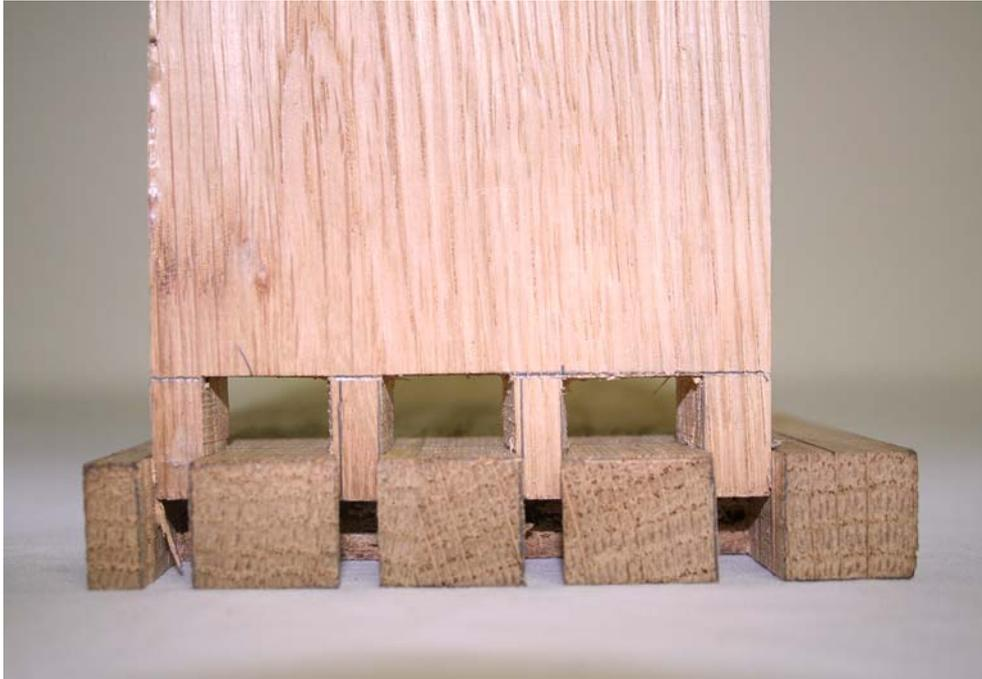
Abb. 6: Einpassen der Verbindung
