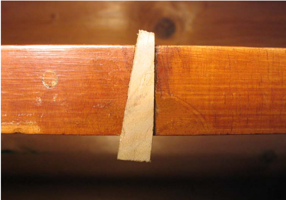
Abb. 9: Eingesetzter Nussbaumkeil an einer Traverse
