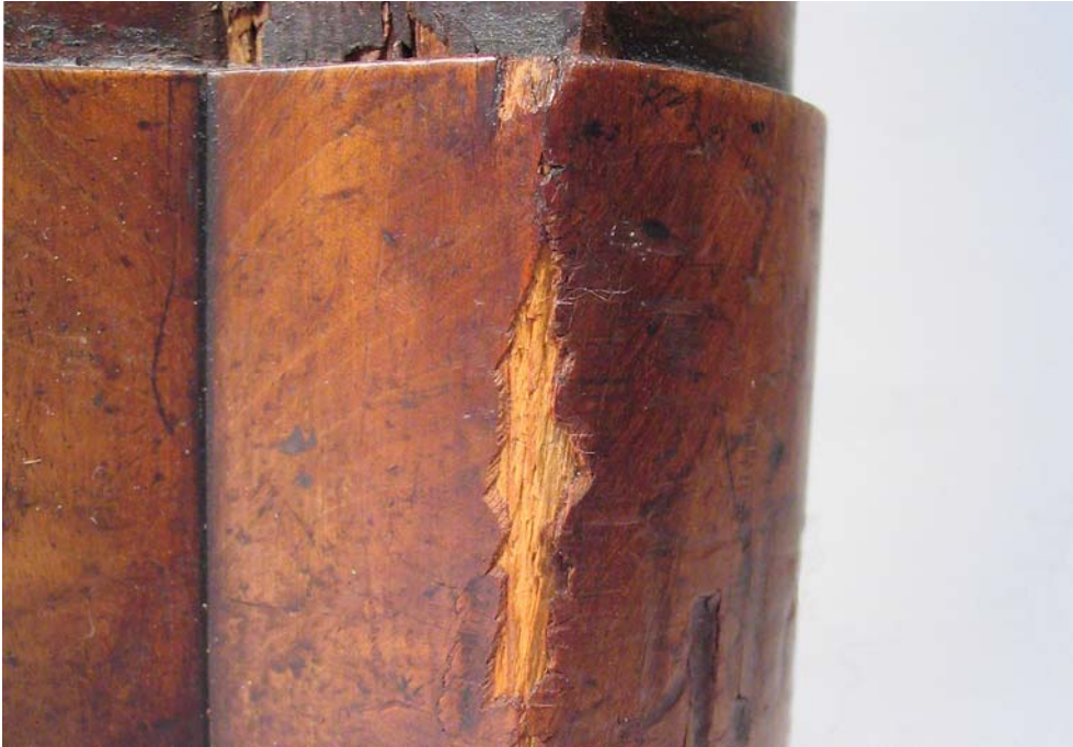
Abb. 2: Heraus gebrochene Furnierstücke am rechten Vorderfuß
